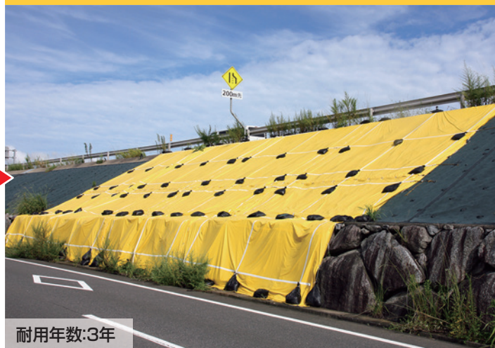
西九州自動車道 唐津IC付近 防災イエロー工法による
