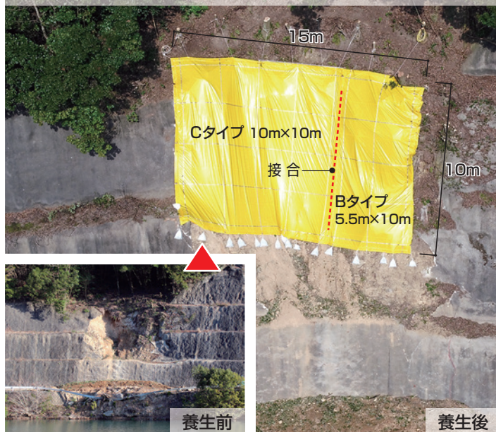
法面崩落部を緊急養生した事例
