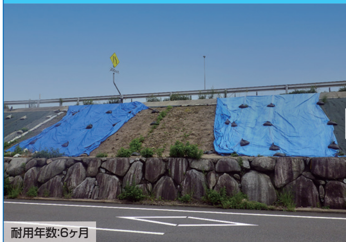
西九州自動車道 唐津IC付近 従来工法による
