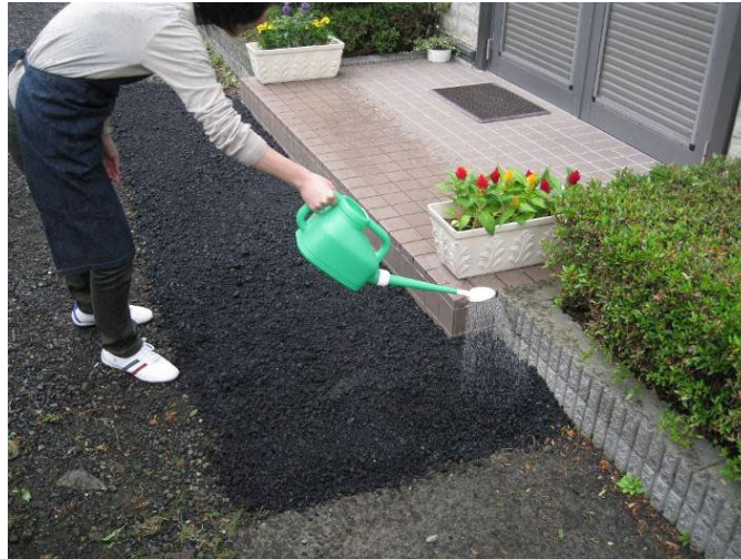
写真－1 マイルドパッチの施工例（住宅回り）
