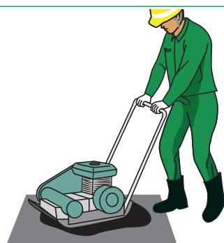
締固め機械等ですぐにしっかりと締め固めます。
